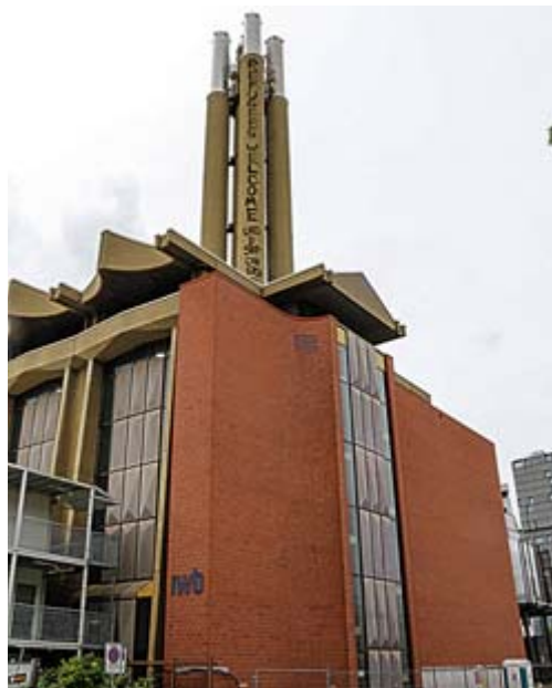
Vandalen haben an Pfingsten unser 68 Meter hohes «Wahrzeichen», das IWB-Heizwerk an der Solothurnerstrasse, beschmiert. Fotos: Thomas P. Weber
