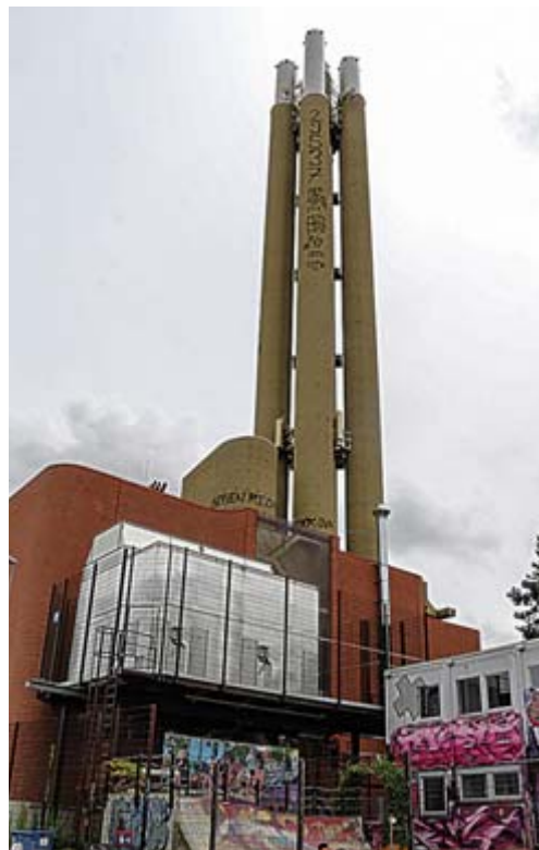
Die versprayten Kamine aus Sicht von der Meret Oppenheim-Strasse.
