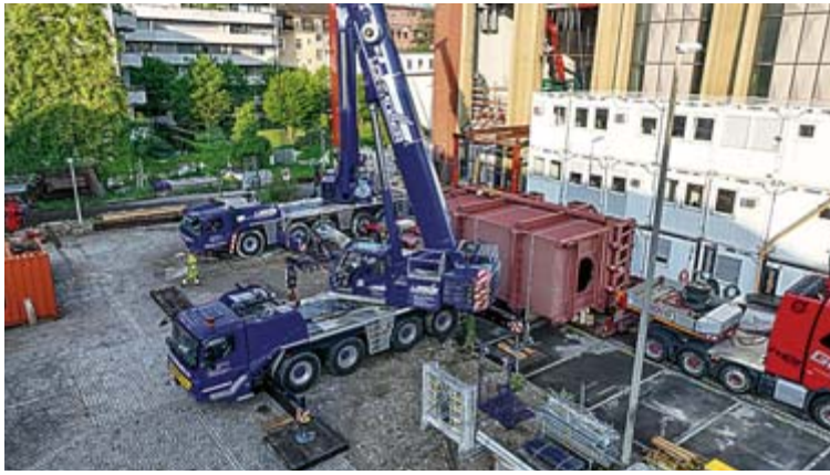
Die neuen Kessel werden ins Heizwerk gehievt.
