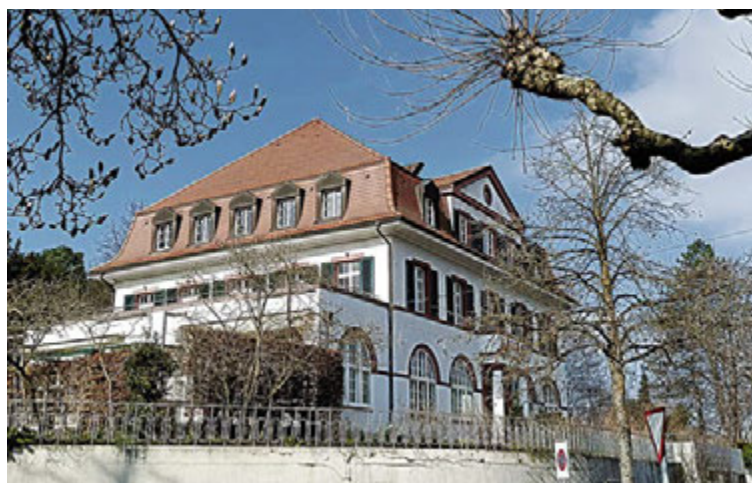
Für etwa 11 Millionen Schweizer Franken wird beim Restaurant Stucki gebaut beziehungsweise angebaut. Foto: Martin Graf
