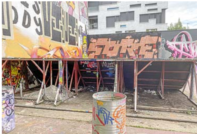
Sichtbares Gerüst der Skateanlage im Purple Park, nach teilweiseem Abbruch. Fotos: zVg/Martin Zbinden
