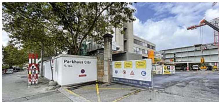
... der neue City-Parking-Eingang in der Hebelstrasse.
