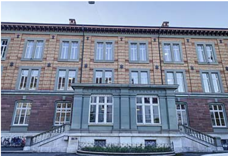
Das Seevogelschulhaus wurde 1884 gebaut, gehört zu den historischen Gebäuden in Basel-Stadt und ist denkmalgeschützt. Fotos: XdS
