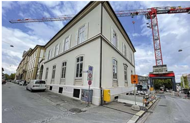
Petersgraben: Rechts der alte City-Parking-Eingang hinter dem Kran und links, ca. 200 Meter ...
