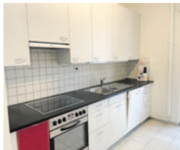
Hat ihren Dienst erfüllt. Die Küche vor dem Umbau
