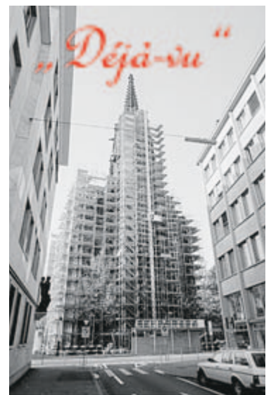
Basel, Elisabethenkirche, Baustelle.
