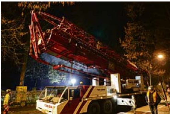
Der mobile 84-Tonnen-Baukran fährt langsam seinen 35 Meter-Arm aus.
