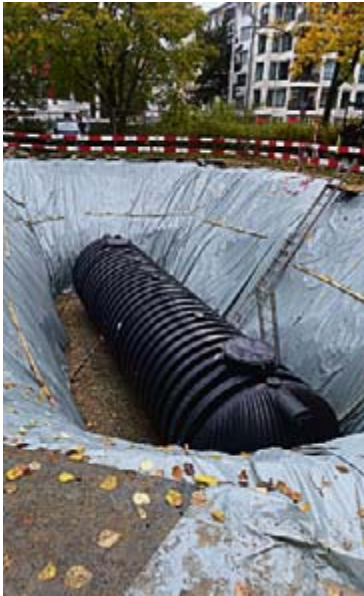
Der neue Retentionstank im Winkelriedplatz für nachhaltiges Wassermanagement. Foto: zVg Baud-Dep. BS
