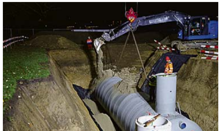
Der Tank wurde erfolgreich versenkt und fixiert.
