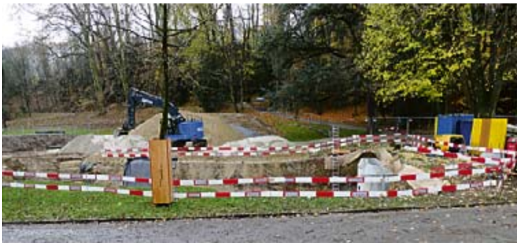
Die Baugrube im Margarethenpark ...
