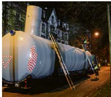
Der Wassertank steht in der Gundeldingerstrasse und wird...
