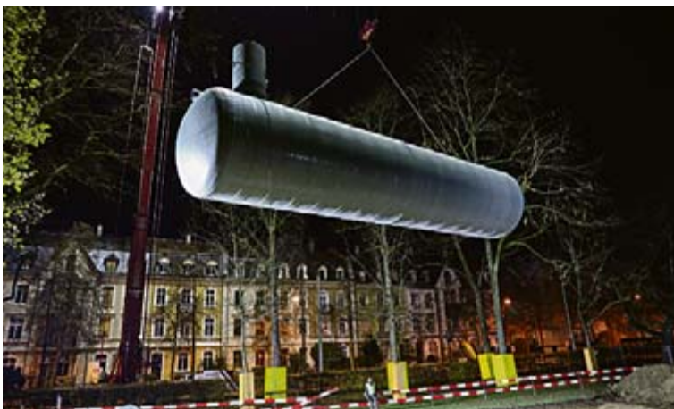
Der 6-Tonnen-Tank schwebend über der Baugrube.
