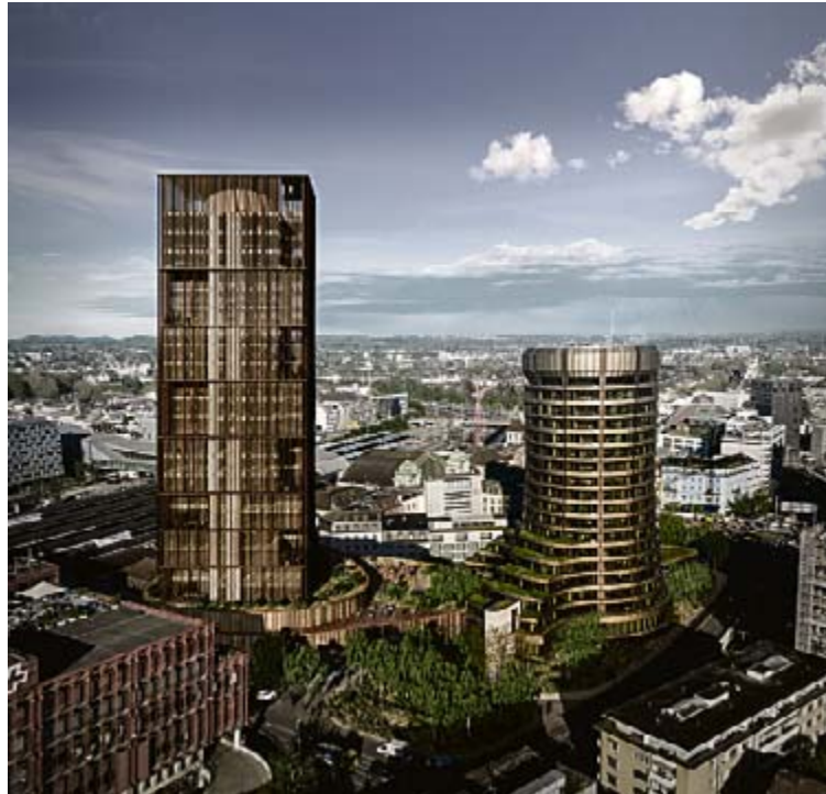
Rechts das bekannte «alte» runde BIZ-Gebäude und links das neue Holzhochhaus an der Centralbahnstrasse.
