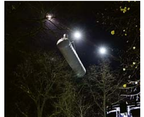
... hoch über die Bäume in den Park gehievt.
