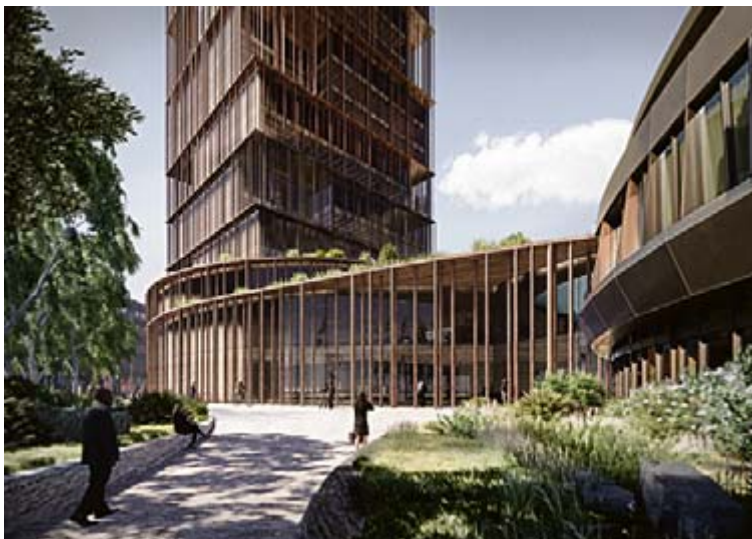
Frontansicht des neuen BIZ-2-Gebäudes mit der «waldähnlichen» Fassade.
