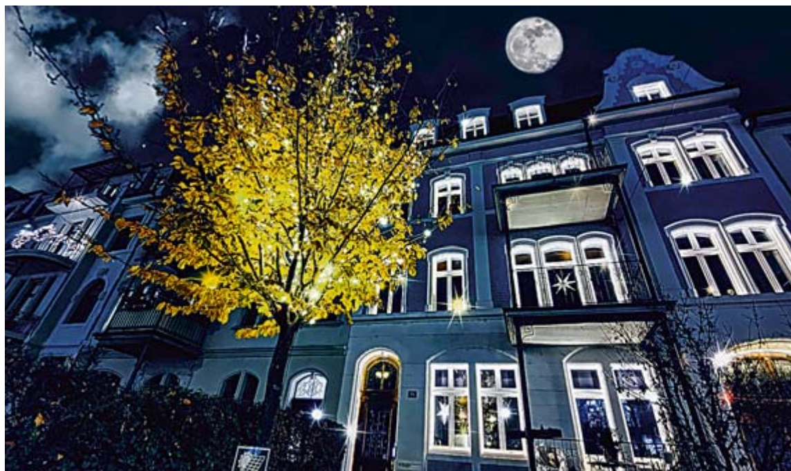
Hell leuchtet das «BSK-Haus» in der Thiersteinallee.
