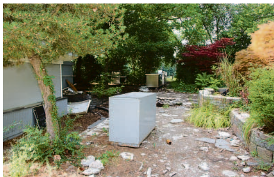
Im Juni/Juli 2019 hat die Eigentümerschaft bereits mit dem «Abriss» angefangen.
