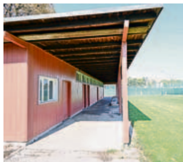
Dieses historische Garderobengebäude müsste wegen dem Neubau abgerissen werden.
