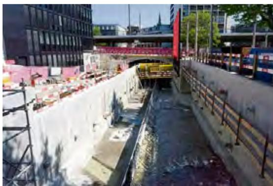
Die linke Mauer wird durch eine Böschung abgedeckt, die Rechte bleibt so stehen.
