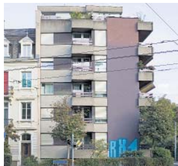
Das Haus an der Ecke Margarethen-/Gundeldingerstrasse
