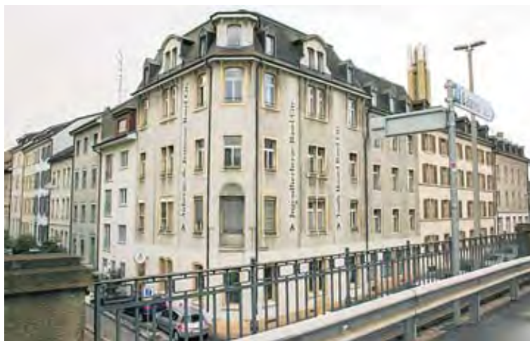
Die Liegenschaften an der Solothurnerstrasse 11, Hochstrasse 4 bis 10 und der Pfeffingerstrasse 8 bis 12, werden voraussichtlich im Herbst 2017 abgerissen.
