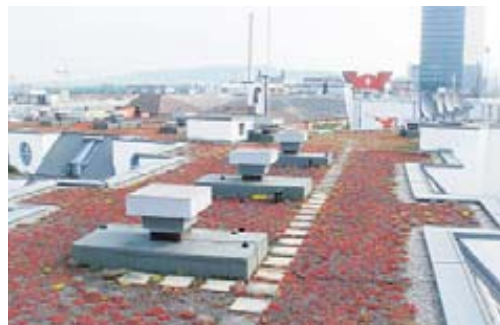
Messe Basel Kongressgebäude, Flachdach-Sanierung.
