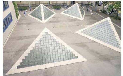
Pyramidenplatz Theater Basel, Flachdach-Sanierung.
