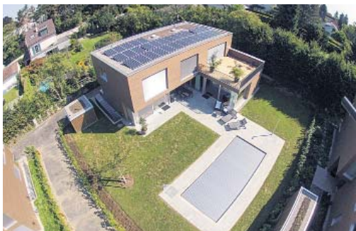
Neubadrain Binningen, Neubau EFH mit PV-Anlage.
