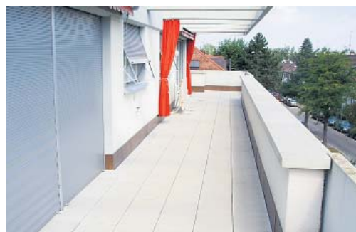
Steinbühlallee Allschwil, Terrassen-Sanierung.
