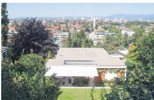
Hasenrainstrasse Binningen, EFH Flachdach-Sanierung.
