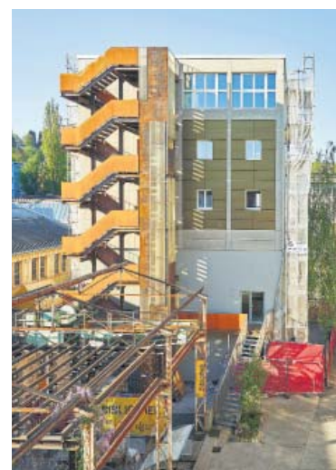
Das neu transformierte Silo-Gebäude im Querfeld. Foto: Martin Zeller
