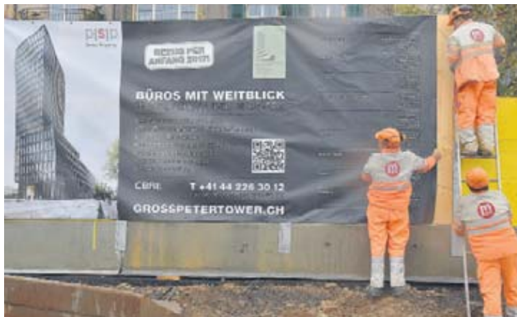
Nach dem montieren der Bautafel, ging es erst richtig los auf der Grossbaustelle in unmittelbarer Nähe zur Autobahnauffahrt.
