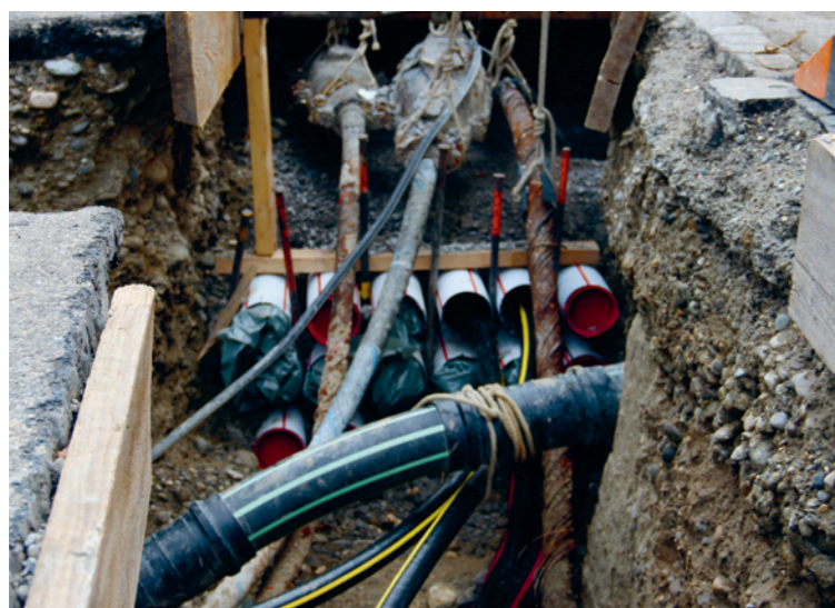
Hier werden Stromkabel erneuert und das Glasfasernetz wird eingerichtet.
