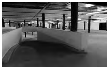
Einblick in die Tiefgarage «Südpark». Foto: J. Zimmermann.
